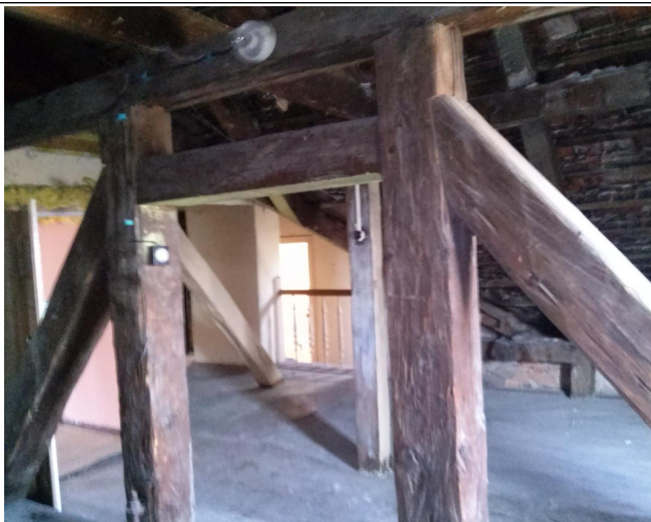
Fot. Konstrukcja drewniana dachu
