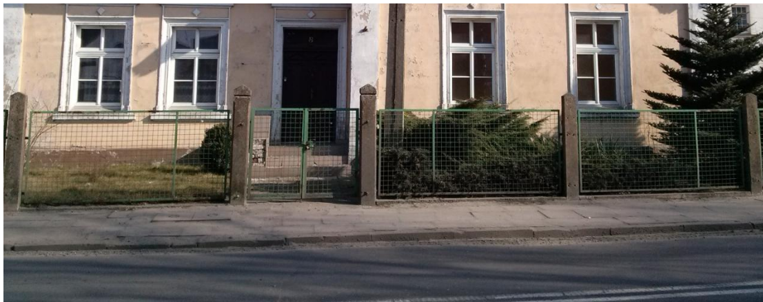
Fot. Ogrodzenie od strony ul. Kościuszki
