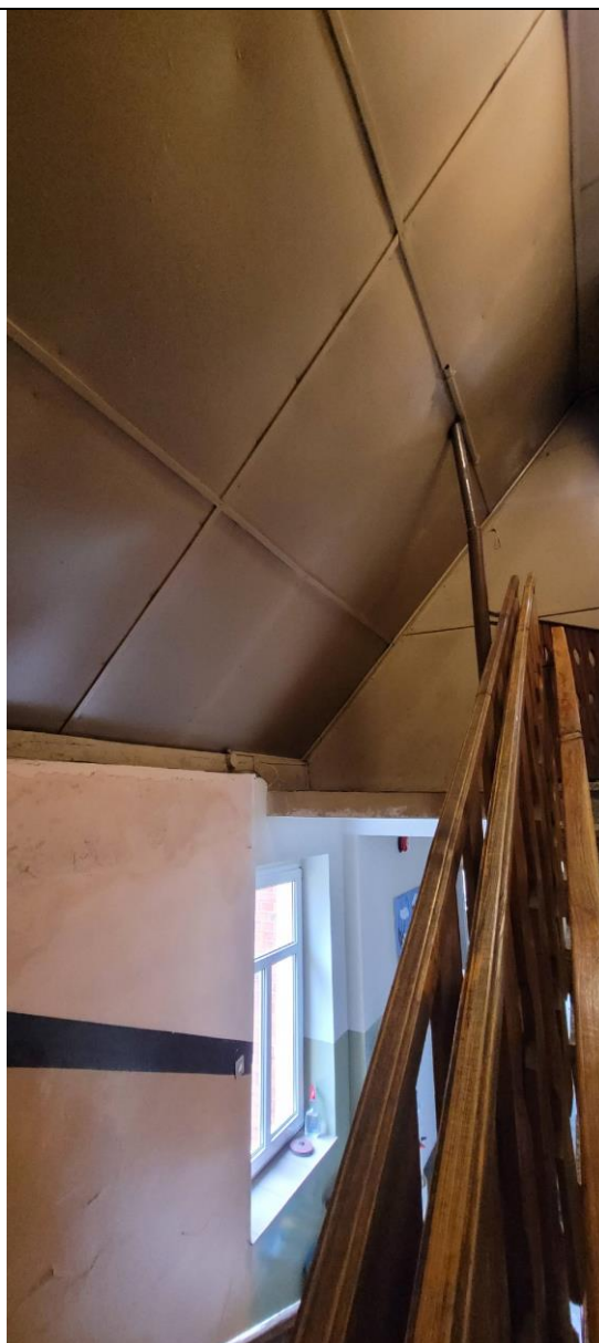
Fot. 7. Wewnętrzna konstrukcja więźby dachowej- widok klatka schodowa
