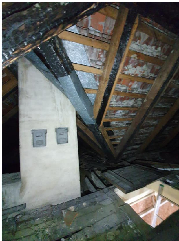
Fot. 3. Wewnętrzna konstrukcja więźby dachowej- stryszek
