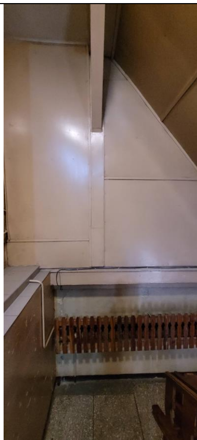
Fot. 6. Wewnętrzna konstrukcja więźby dachowej- widok klatka schodowa
