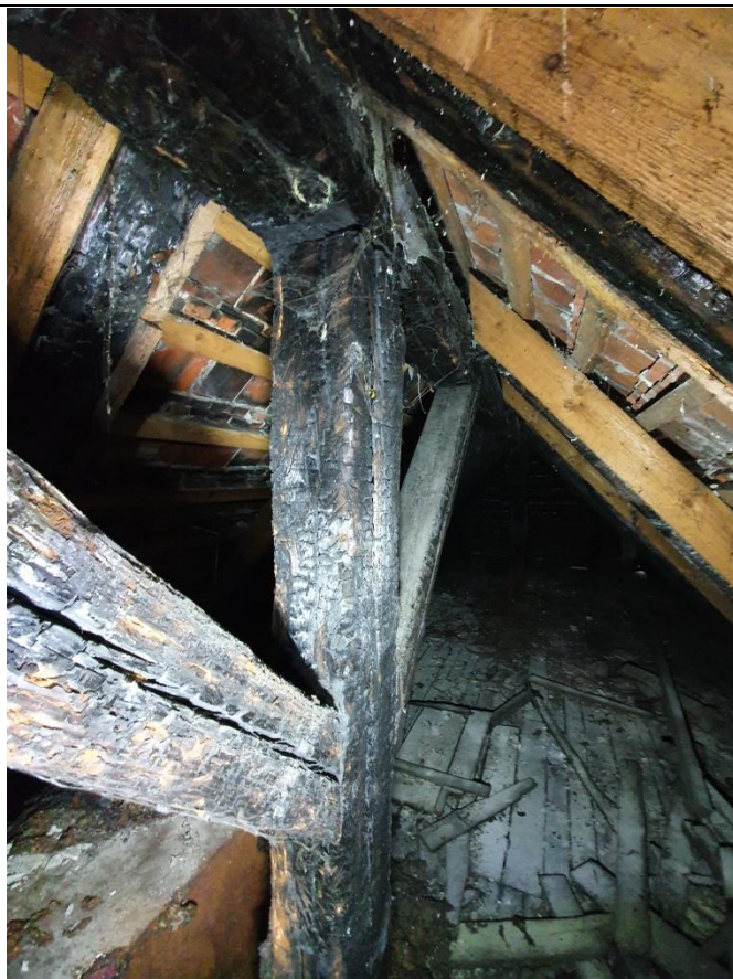
Fot. 2. Wewnętrzna konstrukcja więźby dachowej- stryszek
