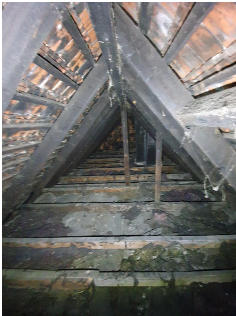
Fot. 1. Wewnętrzna konstrukcja więźby dachowej- stryszek
