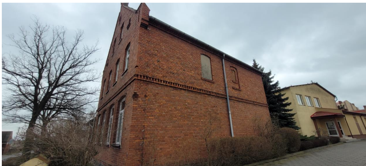
Fot. 3. Elewacja boczna - zachodnia
