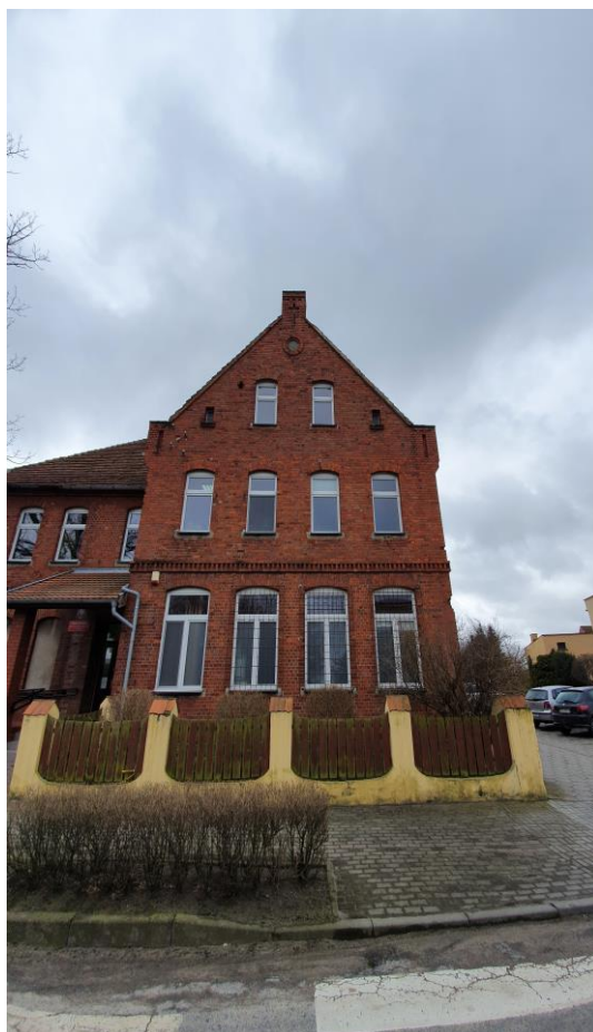
Fot. 1. Elewacja frontowa
