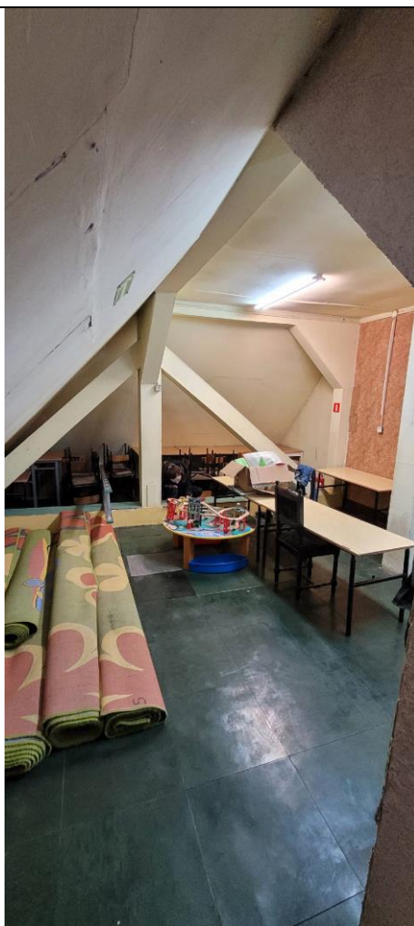
Fot. 4. Wewnętrzna konstrukcja więźby dachowej- poddasze
